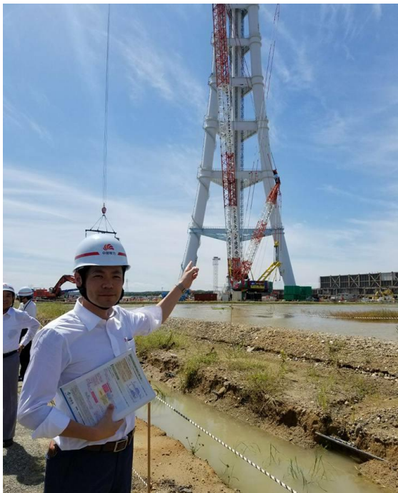
これまで使われてきた石油火力発電の煙突撤去作業を視察する武田良介参院議員（中電武豊火発敷地内）
